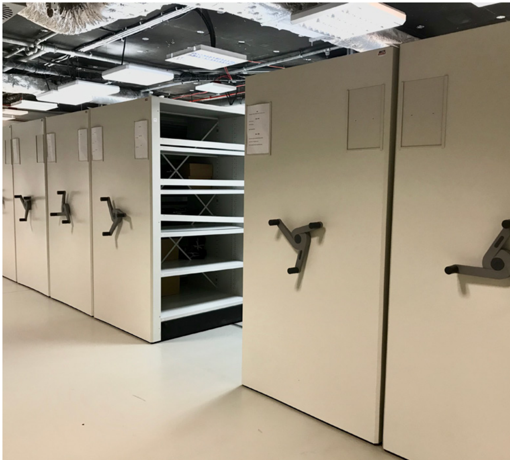
Zdjęcie 6. Regały jezdne wmontowane w podłogę.
