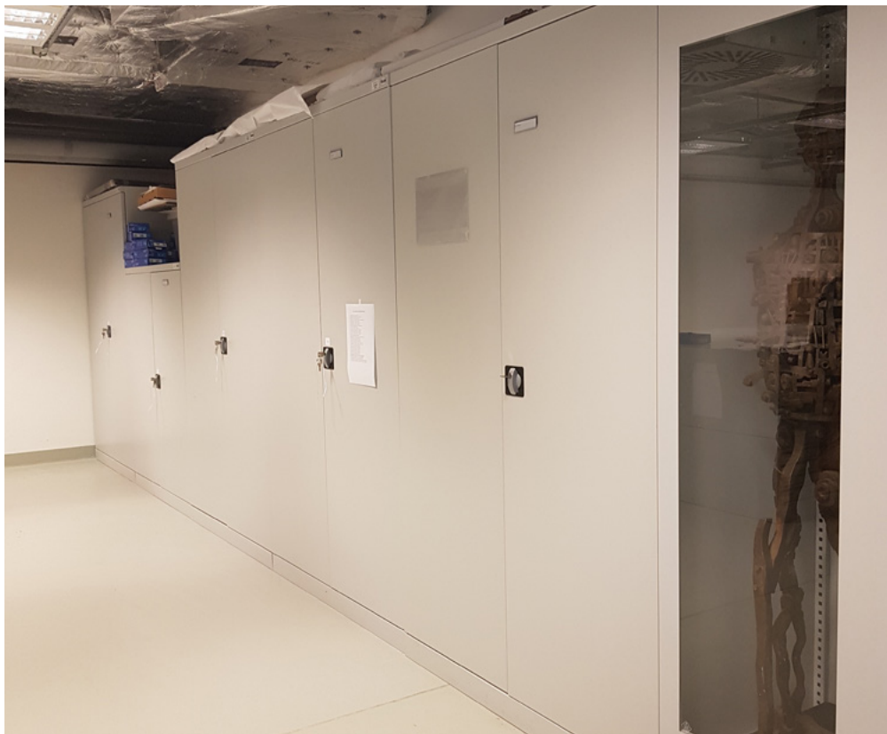
Zdjęcie 5. Przykład zamontowanych metalowych szaf do przechowywania obiektów zabytkowych.
